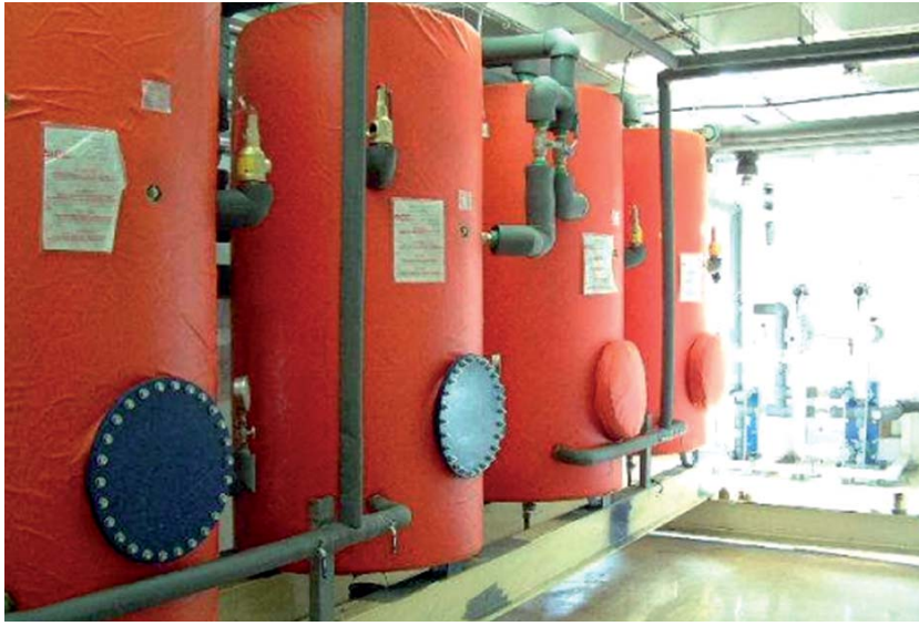
Instal·lació d'ACS del centre d'Asepeyo a Sant Cugat del Vallès
