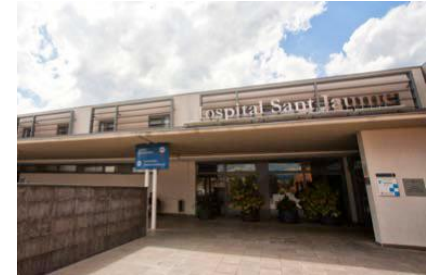
HOSPITAL SANT JAUME DE MANLLEU
