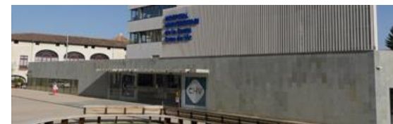
Àrea de Rehabilitació HUSC
