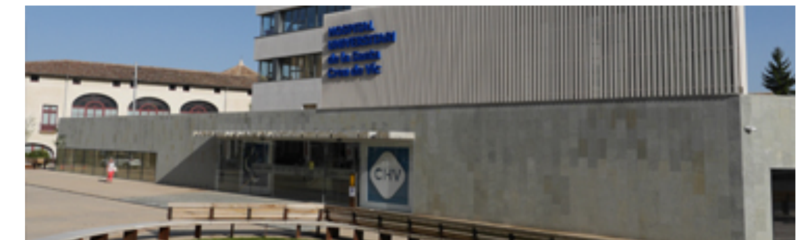
Àrea de Rehabilitació HUSC
